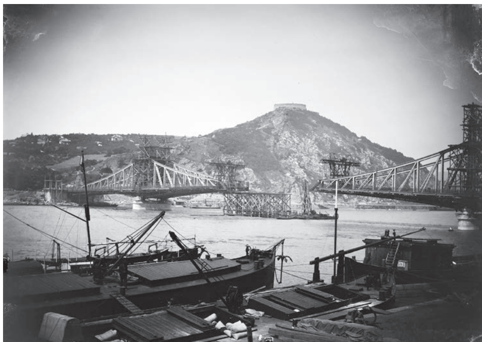
2. ábra. Az épülő Ferenc József (jelenleg Szabadság) híd, háttérben a Citadellával (1900) (Forrás: FORTEPAN. Képszám: https://fortepan.hu/hu/photos/?id=204236 )
