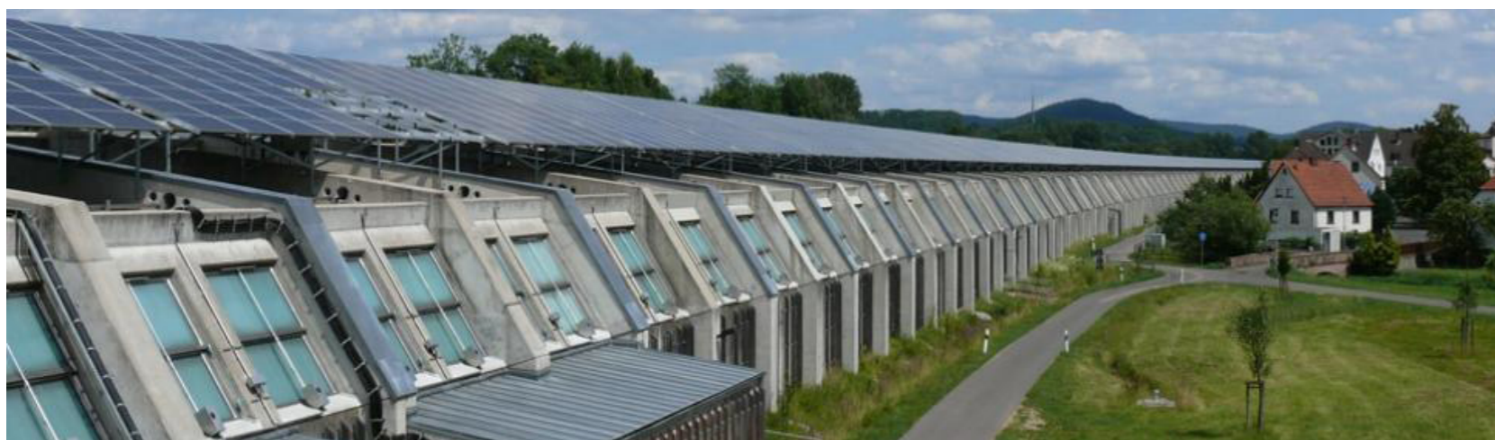
90. ábra. Az autópálya fölött kialakított napelemes rendszer Hösbach (Németország) térségében ( http://www.oksolar.com/media/commercial-building-rooftop-solar-power-system.html )
