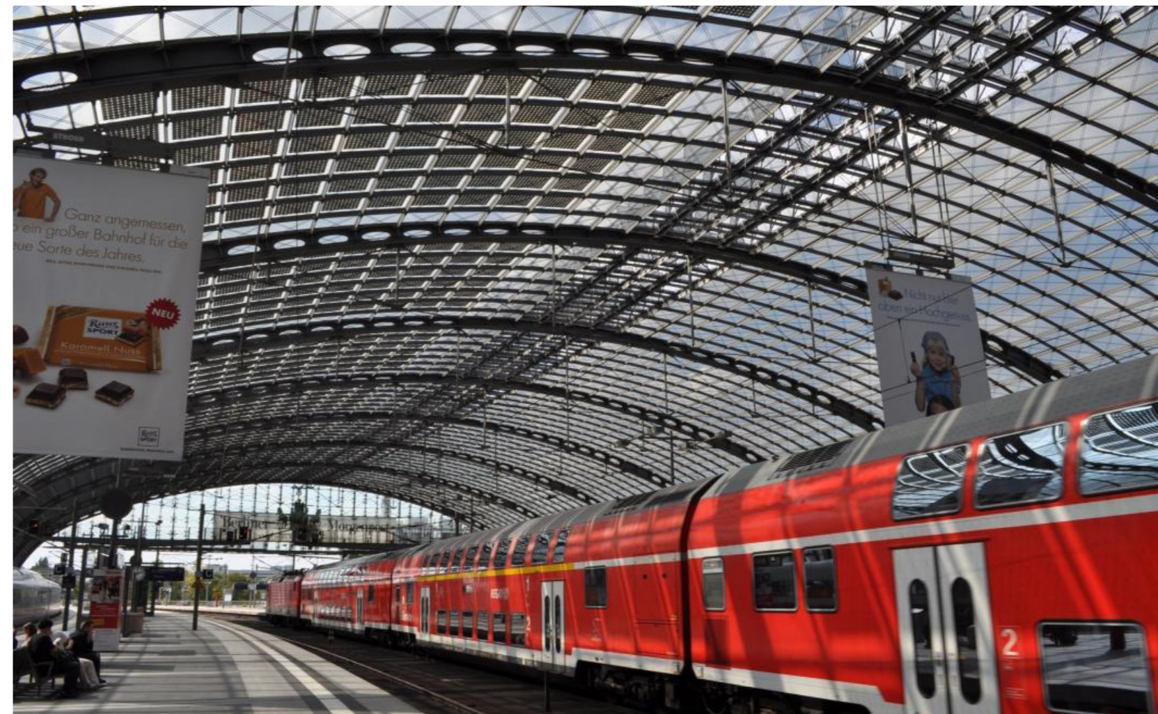
82. ábra. A tetőbe integrált napelemes (Building Integrated Photovoltaic) alkalmazás a berlini főpályaudvaron (fotó: Munkácsy B.)
