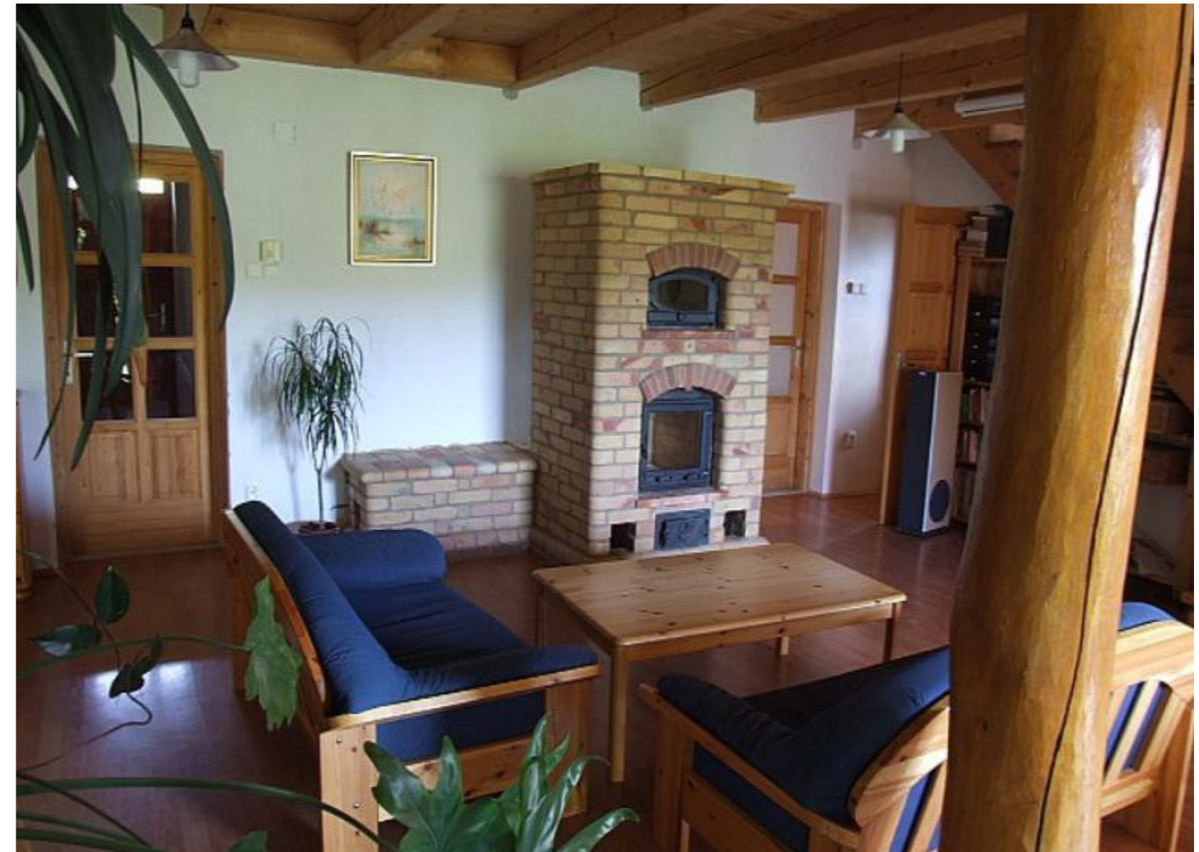
103. ábra. Használati meleg víz készítésére is alkalmas tömegkályha (fotó: Munkácsy B.)
