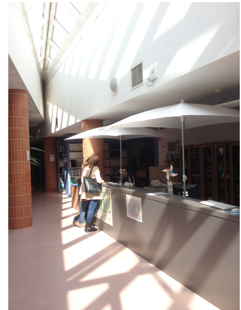
56. ábra. A tervezők által megálmodott tetőablakok miatt tavasztól ősziig a könyvtárhelyiség túlmelegszik, ezért az intenzív (és energiafaló) légkondicionálás ellenére a munkatársak napernyők alatt kénytelenek dolgozni az ELTE Lágymányosi Campusán
