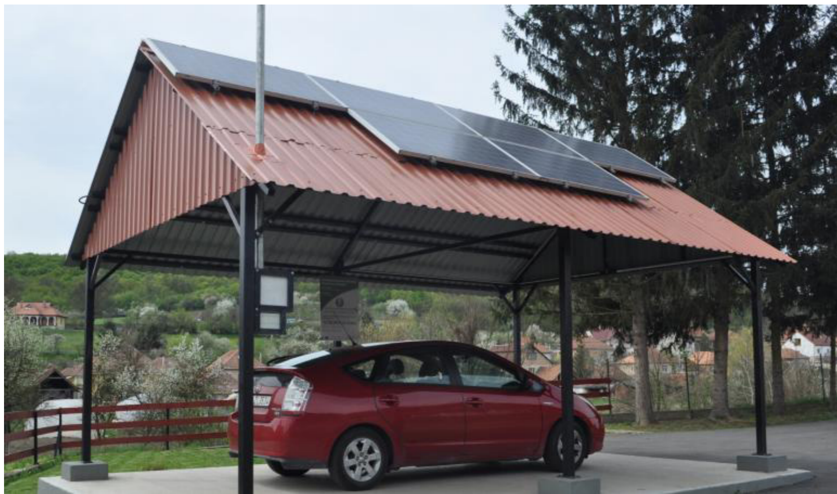
49. ábra. A déli oldalra már nem fért el, így az északira is jutott azokból a napelemekből, amelyeknek egy elektromos autók töltésére szolgáló állomás energiaellátását kellene fedezniük egy bükkaljai kistelepülésünkön. Ez egy olyan alapvető méretezési hiba, amely egyszerű osztással-szorzással megelőzhető lett volna (Fotó: Munkácsy B.)
