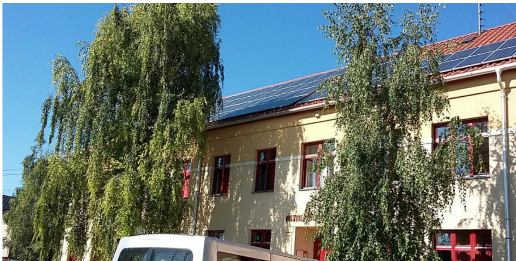
92. ábra. A települési környezetben megjelenő napelemek és az oda nem való fafajok konfliktusa: a keleti oldalon még a magas iskolaépület tetején lévő napelemek is szinte folyamatosan árnyékban vannak (fotó: Munkácsy B.)
