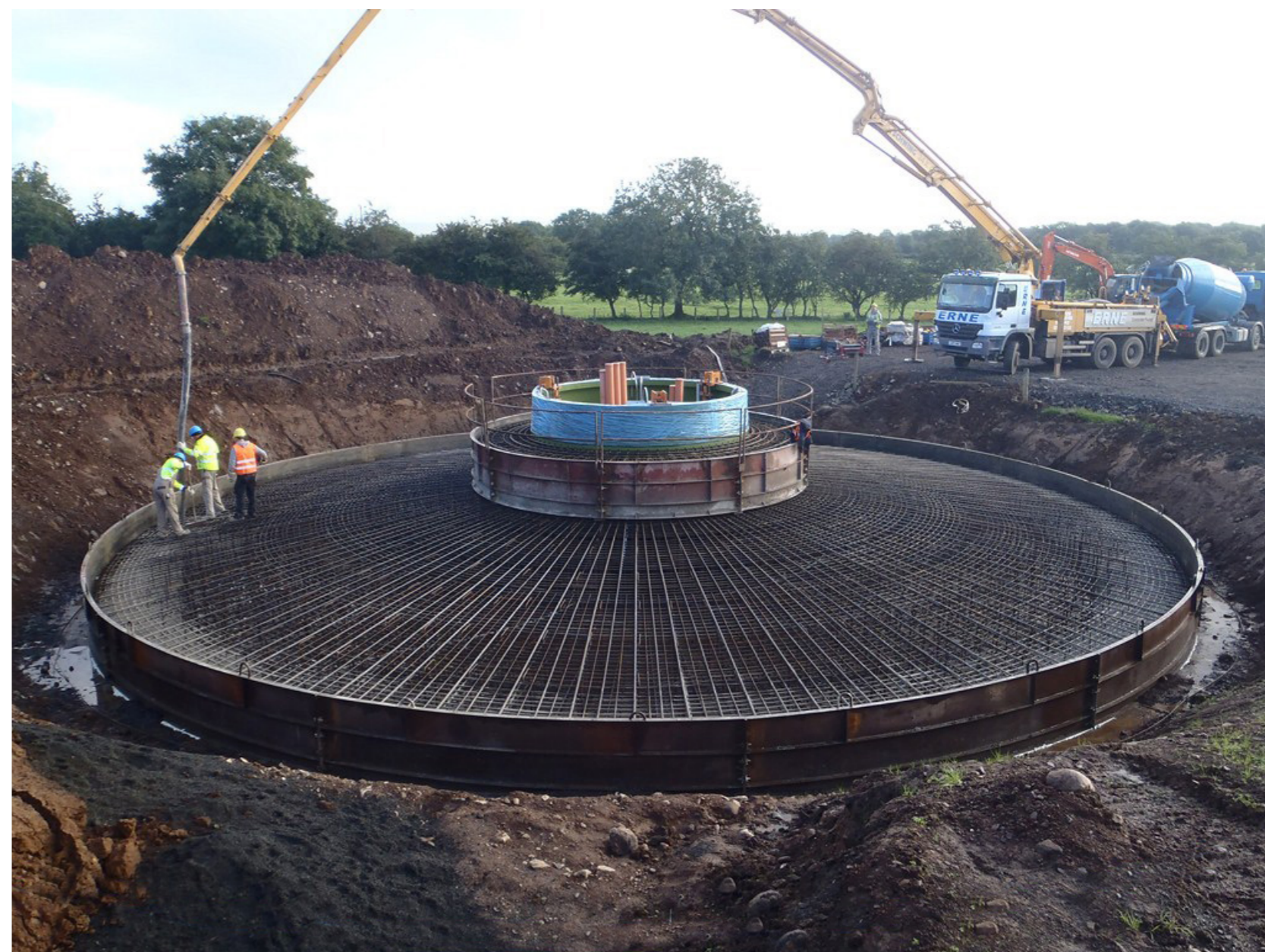
151. ábra. A betonozott alap átlagosan 4-5 napig készül, átmérője 15-20 méter, betonigénye 800 m 3 (fpmccann.co.uk/)
