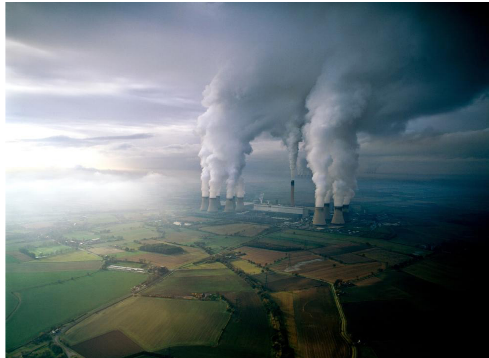
40. ábra. A Drax (Egyesült Királyság) a világ legnagyobb és legkevésbé hatékony biomassza-tüzelésű erőműve – a hűtőtornyokon kibocsátott hővesztés ~8000 MW felhasználatlan hőteljesítményt jelent (3960 MW villamos teljesítmény mellett) – (fotó: TheWritingZone, flickr)
