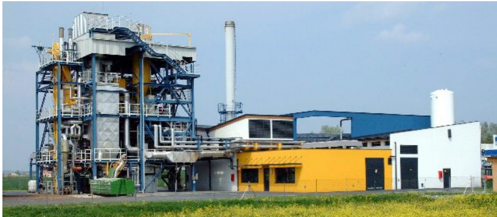
102. ábra. A faelgázosítás elvén működő kogenerációs erőmű (2 MWp + 4,5 MWth) Güssingben, amely igény szerint a fából szintetikus bioüzemanyagot és biogázt (Synthetic Natural Gas) is előállít. Figyeljünk a léptékre! ( http://wiki.peaproject.eu/ )
