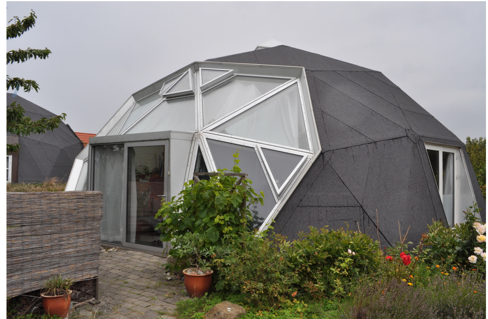
73. ábra. Passzív napenergia-hasznosítás indirekt megoldással – Dyssekilde, Dánia (fotó: Munkácsy B)
