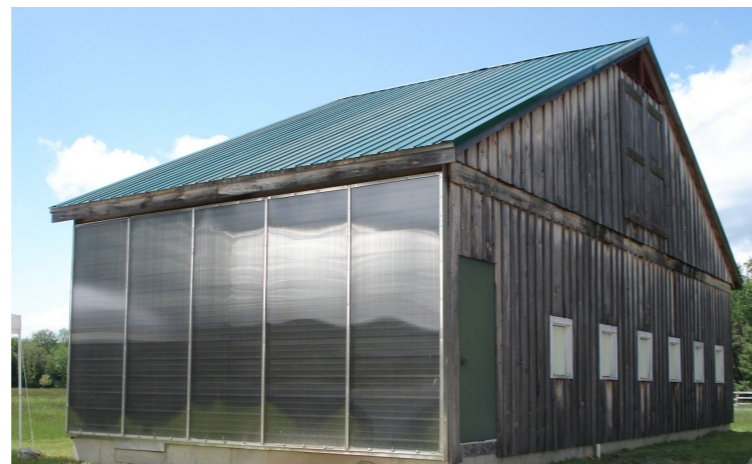
77. ábra. Léggelkolltorral felszerelt épület ( http://www.greenbuildingadvisor.com )
