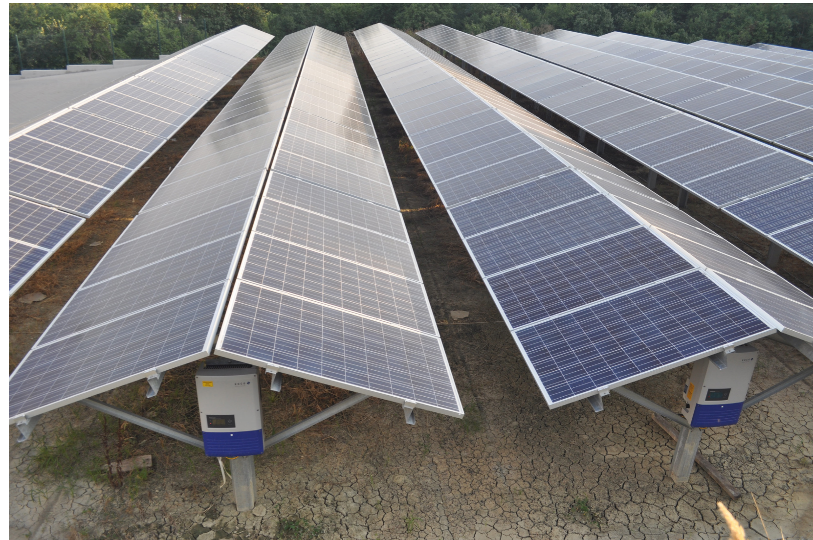
89. ábra. Napelemes rendszer keletre és nyugatra tájolt napelemfelületekkel, Tibolddaróc (fotó: Munkácsy B.)
