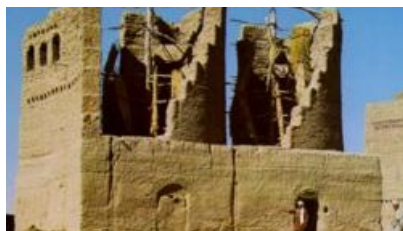
2.1. ábra: Perzsiai függőleges tengelyű szélmalomok
