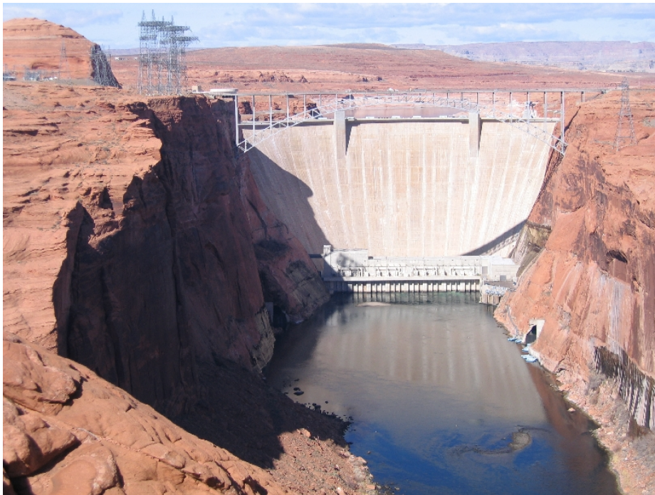
5.8. ábra: Az 1964-ben üzembe helyezett Glen-kanyon gát, melynek magassága 220 m. A hasznosítható esése meghaladja a 150 m-t. Beépített kapacitása: 1296 MW. Átlagosan évente csak a teljes kapacitás negyedét használják ki. A legtöbb termelt energia 1984-ben 10,4 TWh volt, a legkevesebb évi energiatermelés mintegy 2 TWh volt 2002-ben. Az átlagos energiatermelés 3,454 TWh/év.
