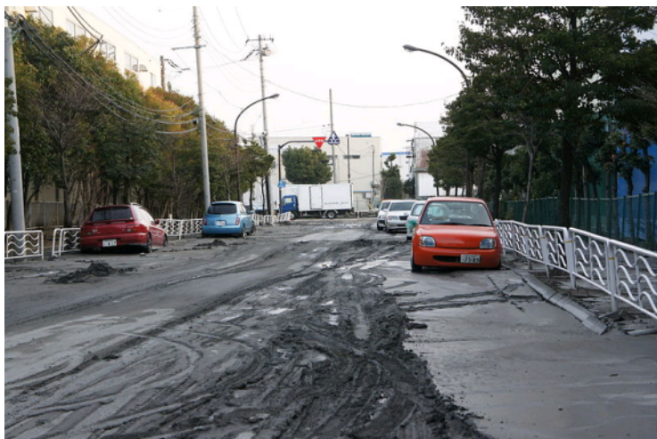
6.23. ábra. A talaj elfolyósodása Tokióban a földrengés következtében (Forrás: http://upload.wikimedia.org/wikipedia/commons/8/8f/Soil-liquefaction_at_Shinkiba_after_2011_Tohoku_Pacific_Ocean_offshore_earthquake.jpg )
