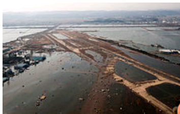
6.37. ábra. A szökőár által elöntött Sendai repülőtér (Forrás: http://upload.wikimedia.org/wikipedia/commons/5/54/SendaiAirportMarch16.jpg )
