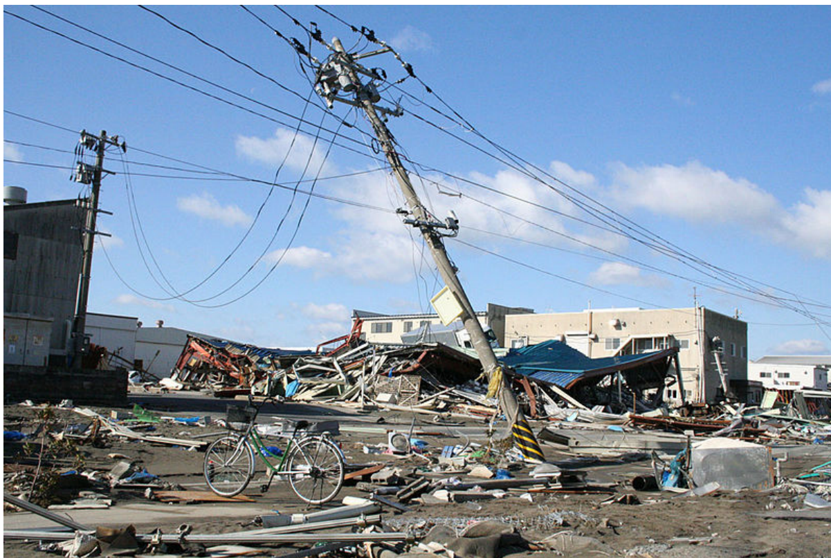
6.39. ábra. Megrongálódott áram- és telefonvezeték Ishinomakiban (Forrás: http://upload.wikimedia.org/wikipedia/commons/d/d0/Fallen_power_poles_in_Ishinomaki.jpg )
