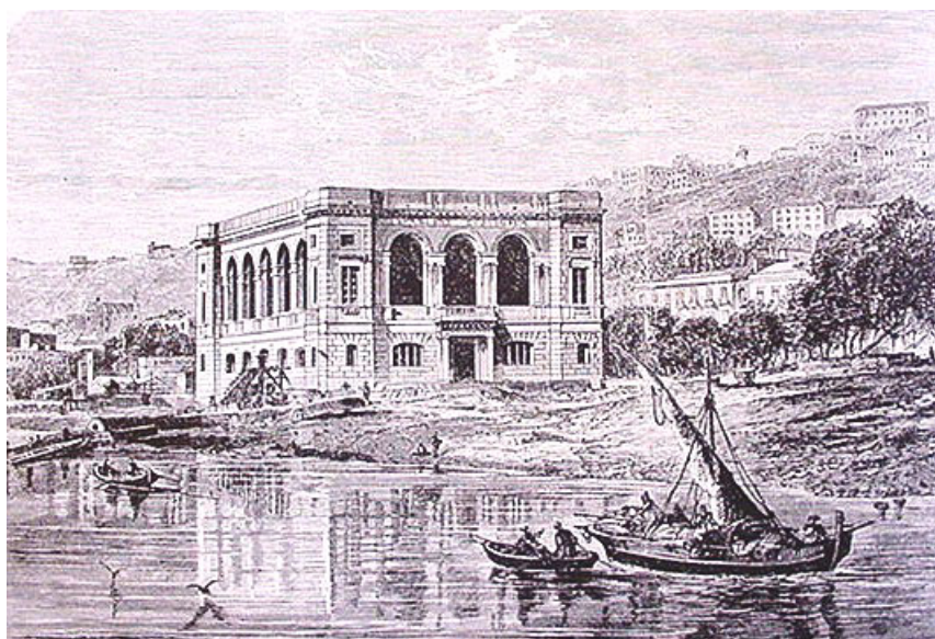
1.4. ábra Nápolyi tengerkutató állomás épülete
